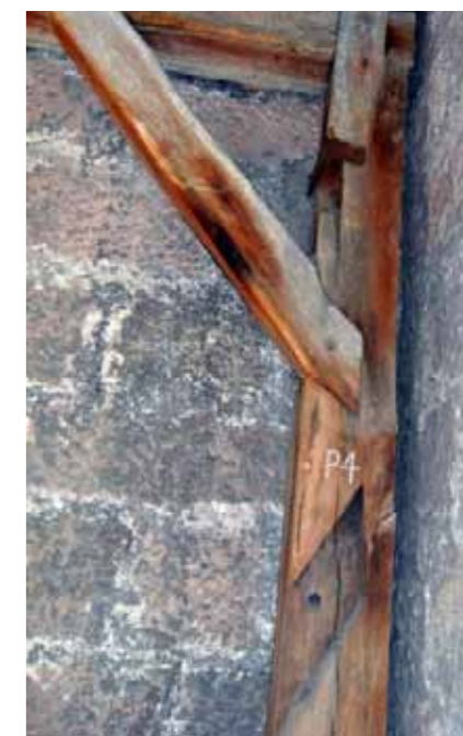
Abb. 2 Balken im Uhrwerksgeschoss des Südturms
