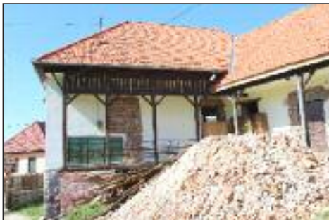
Hospiz in Malnas im Bau.
