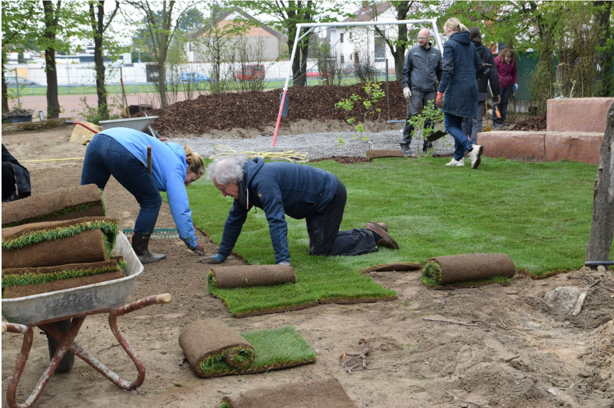
Rollrasen wird verlegt
