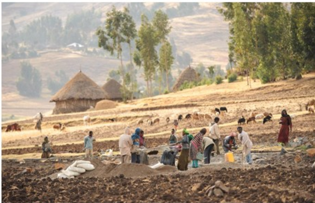
An den Bauarbeiten für das neue Kanalsystem sind die Bewohnerinnen und -bewohner des Dorfes Anberbir beteiligt.
